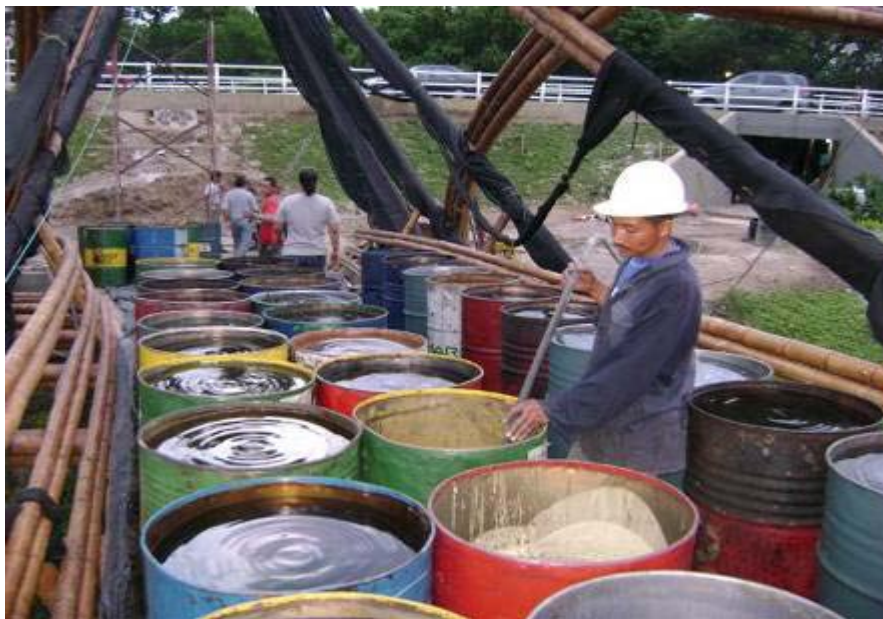
Foto 26: Durante la prueba de carga se verifica la deformación causada por barriles de 200 kg. Después se cruza los datos del análisis estructural con los ensayos de carga.
