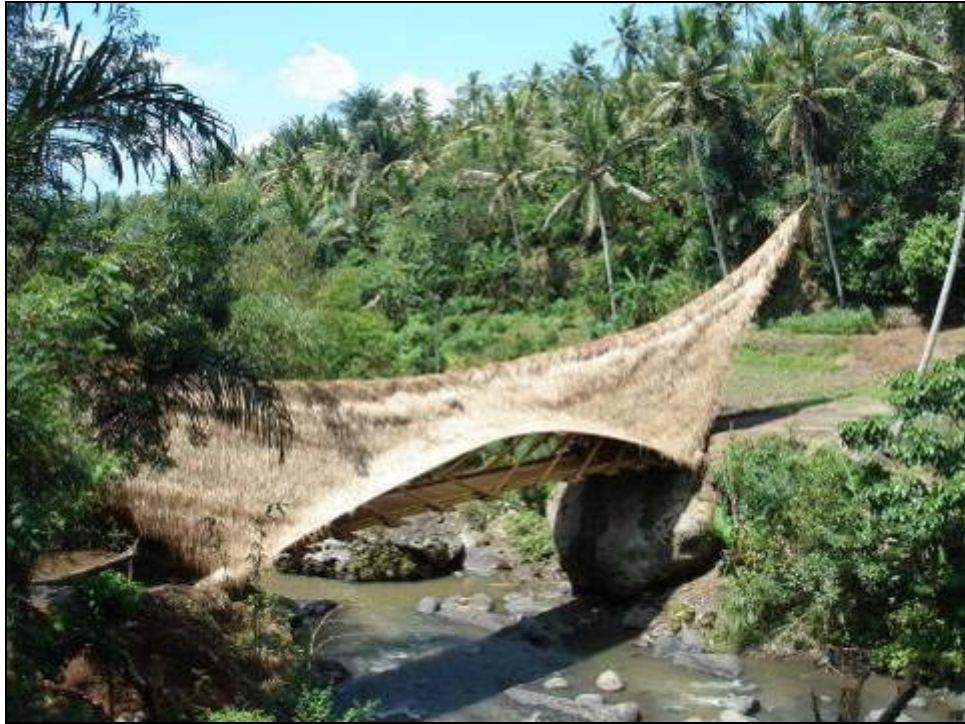
Foto 15: Puente de 22 metros del “Greenschool” in Sibang, Bali, Indonesia. Los dos “cuernos” son típicos de la cultura Minang Kerbau en Sumatra y generan una circulación natural de aire fresco. Aquí sirven algo de contrapeso y generan 4 grandes escudos que se soportan en el centro.
