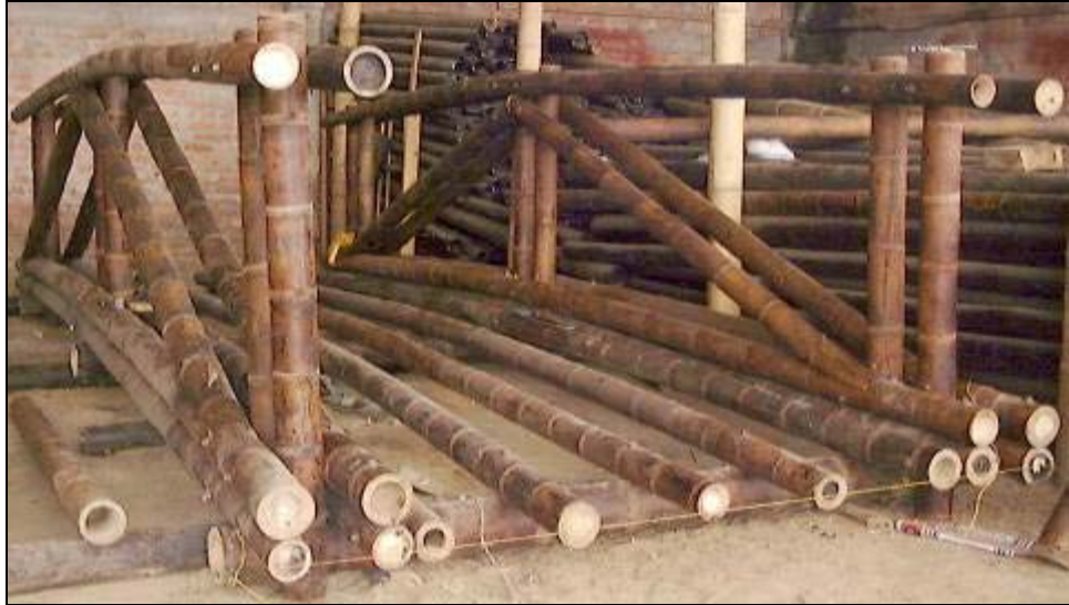
Foto 18: Puente de 6 metros con cercha REY, Jardín Botánico de Medellín, 2000. Pre-ensamblado, caben varias cerchas en un camión. El techo puede ser de teja o de paja, sobre unas estacas que se introducen en medio de los barandales.
