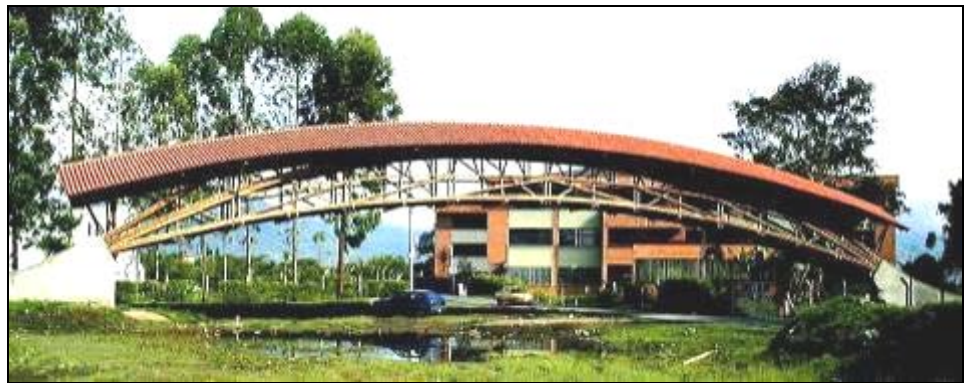
Foto 7: Puente UTP, Pereira, curso de construcción en el año 2000. El arco de guadua cuenta con una cercha con diagonales atirantados contra cargas asimétricas. El puente abraza 40 metros, el piso debe garantizar un galibo de 5 metros. La prueba de carga moderada, con 250 \text{ kg/m}^2 , bajo el arco por solo un máximo de 4 cm y se recupero 3,8 cm. Esta deformación permanente esta causado por el apretón de las fibras en contacto con la rosca de los pernos. El puente también sobrevivió un impacto lateral con una volqueta, sin consecuencias.
