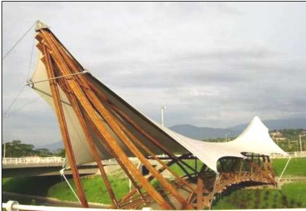
Foto 13: La membrana de 400 m 2 permite la protección contra sol y agua. Su cableado está activamente incorporado a fijar la estructura de las torres y usa se el piso cerca del centro como contrapeso. A pesar que el
