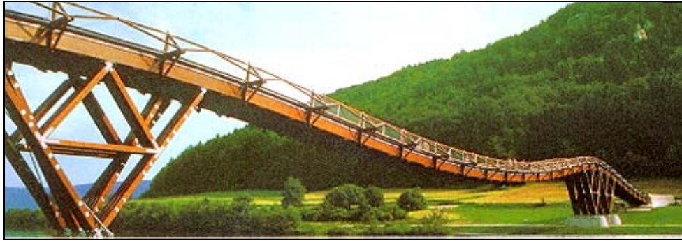
Foto 10: Puente para la ciclo vía a lo largo del Canal del Rhin al Danubio, valle del río Altmühl, Alemania, 190 metros de cinta sin fin en madera laminada siguen la curva de los momentos sobre dos apoyos. La vía es el techo para dar protección por diseño a la madera no tratada químicamente. La sección de los 6 cordones es de 20 x 60 cm. Las tres secciones se unieron in situ con fingerjoint .
