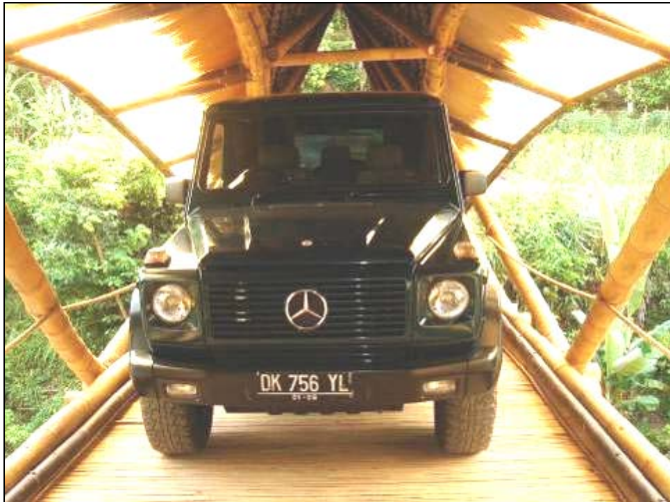
Foto 16: Los dos Arcos esta compuesto de 3 bambúes de Dendrocalamus asper , interconectados por pernos y chazos. El Piso se hizo con listones de bambú que han sido desechados por ser rajado.
