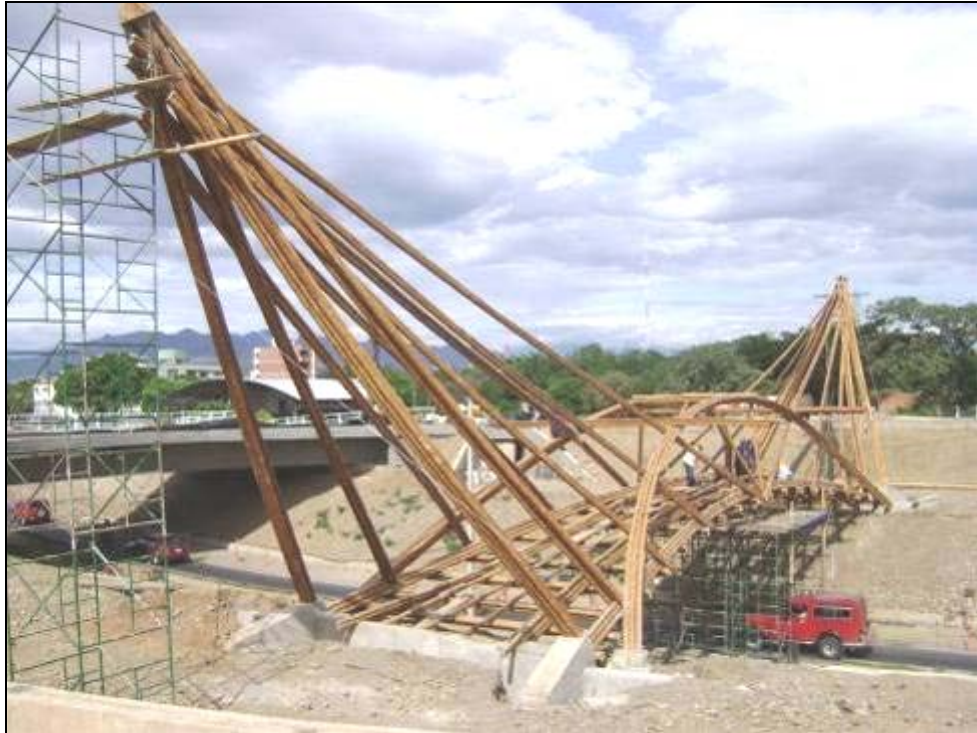
Foto 12: El arco está compuesto por 6 guaduas, estabilizadas por tirantas. Las primeras "tirantas" son en verdad compresores de una torre, que adicionalmente se retiene con el cable que tensiona la membrana.
