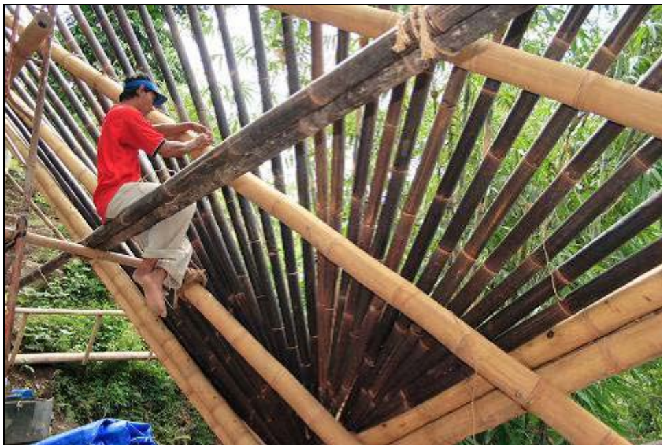
Foto 14: Las dos direcciones opuestas del bambú amarillo y del negro crean rombos (entonces todavía no están determinadas), pero la capa final de listones envueltos en paja, amarados en la estructura, lo conjura como una sola superficie con forma activa.
