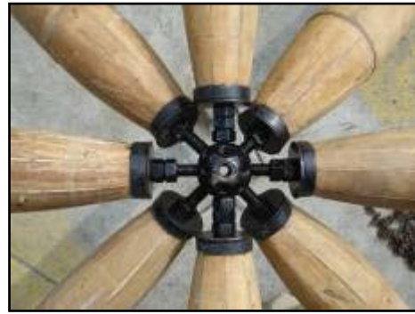
Foto 21, 22: Fijación axial de pernos en uniones cónicas de bambú y bola MERO.
