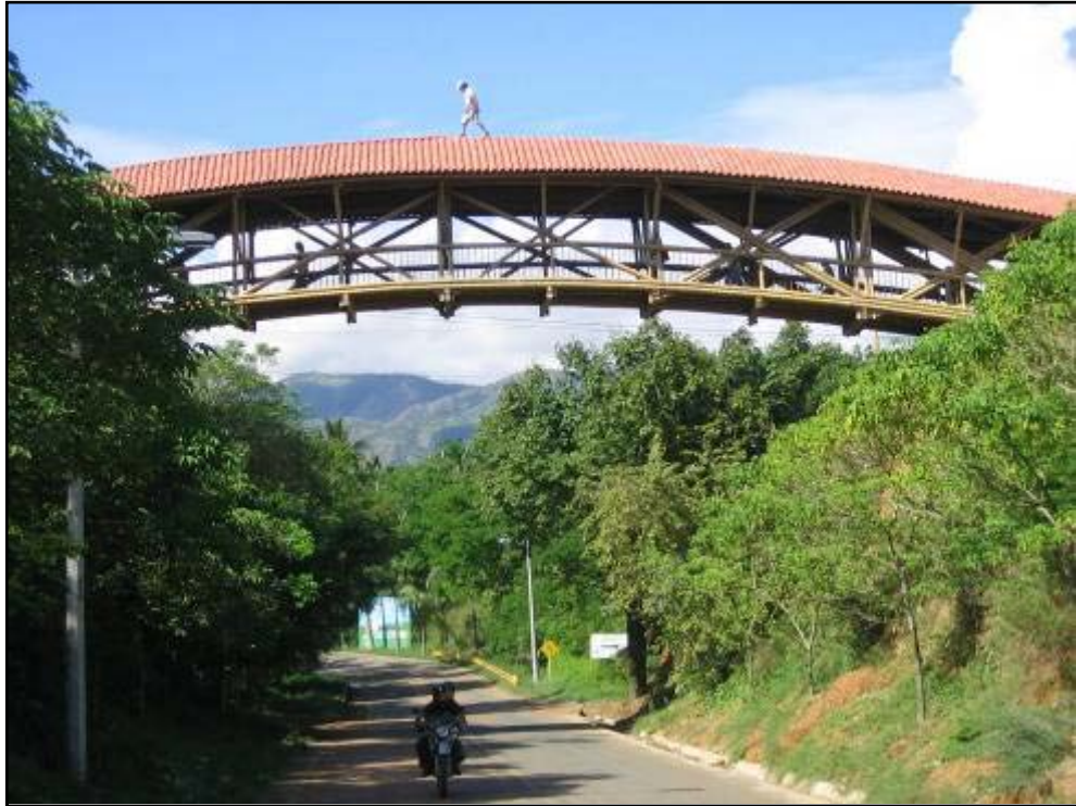
Foto 19: Puente de 30 metros de Santa Fe de Antioquia. La estructura pesa solo 8 toneladas y fue llevado integro por una grúa móvil del sitio de ensamble a los estribos. La operación duro solo 2 horas, el puente entero se hizo en un mes.
