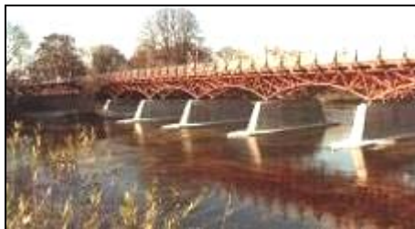
Foto 23, 24: Esquema del puente espacial en madera sobre el Río Isar, Alemania.
